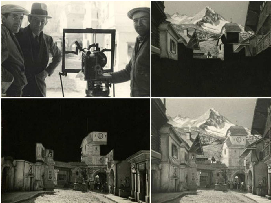
Abbildung 2.5: Dieses Bild zeigt die Glasscheibe, welche vor die Kamera gesetzt wurde (links oben), das gemalte Bild (rechts oben), das Set (links unten) und dann die zusammengesetzte Szene (rechts unten) [81].
